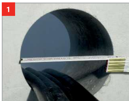
1 výchozí stav: kabely v pažnici nebo jádrovém vývrtu, očistit, odmastit
