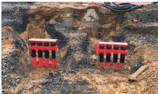
univerzální koncovky se stahovacími nerezovými páskami
